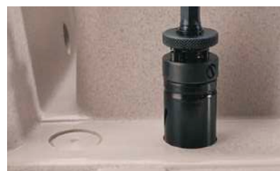
C - Procedere con il completamento del foro
