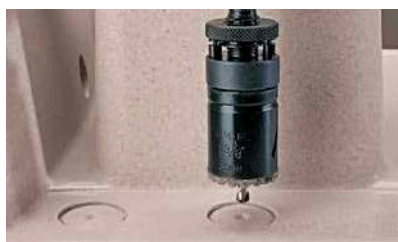
B - Posizionare la fresa in corrispondenza del prefioro
